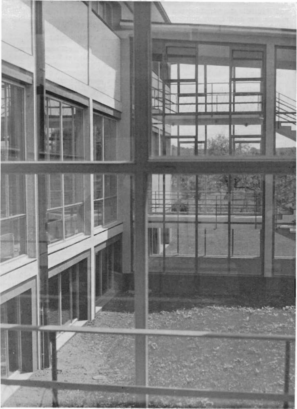
Blick durch das Treppenhaus
