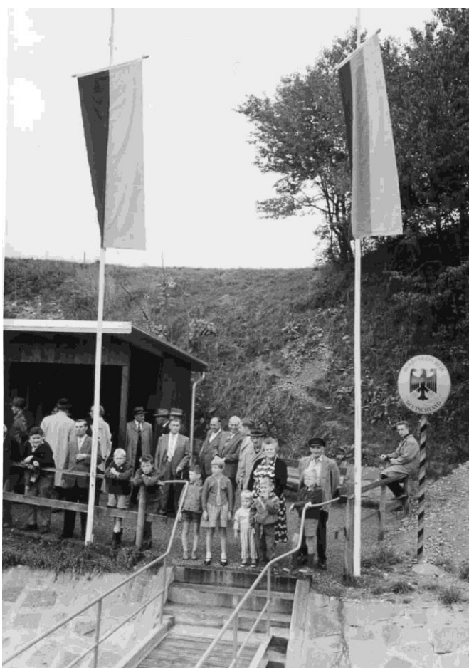
Man wartet, nach langer Unterbrechung am neuen Steg gespannt auf die Fähre für die erste Überfahrt nach Schweizerhalle. Das Zoll- und Wartehäuschen ist ebenfalls errichtet. Die Fähre ist die „Grenzach“, die zwischen Muttenz und Grenzach und nun auch zwischen Wyhlen und Schweizerhalle pendelt. Archiv ZeitzeugenGW
